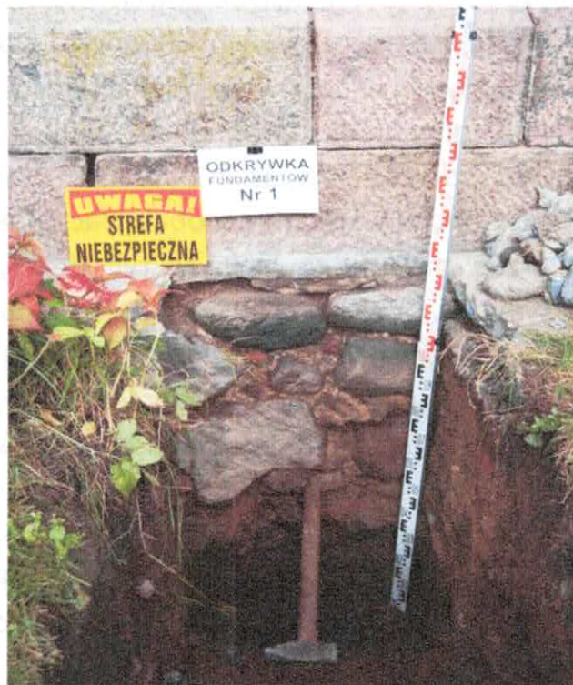
Fot. 1,2 Odkrywki kontrolne nr 1 i 2 fundamentów kościoła
