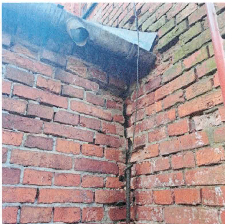
Fot. 13 Szczegół przedstawiający stan porażenia murów elewacji kościoła przez mikroorganizmy
