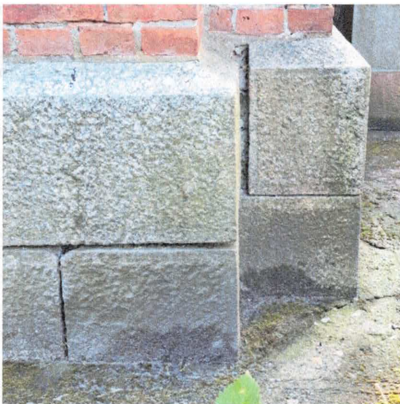
Fot. 18 Szczegół przedstawiający brak spoinowania ciosów kamiennych cokołu elewacji kościoła
