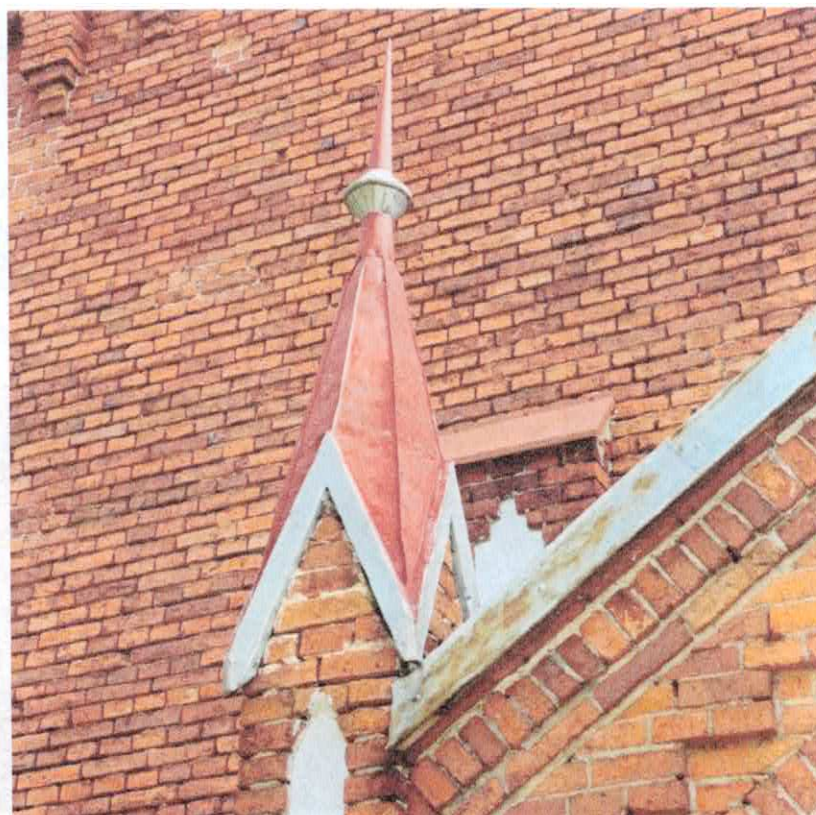
Fot. 21 Szczegół przedstawiający istniejący stan obróbek blacharskich sterczyn
