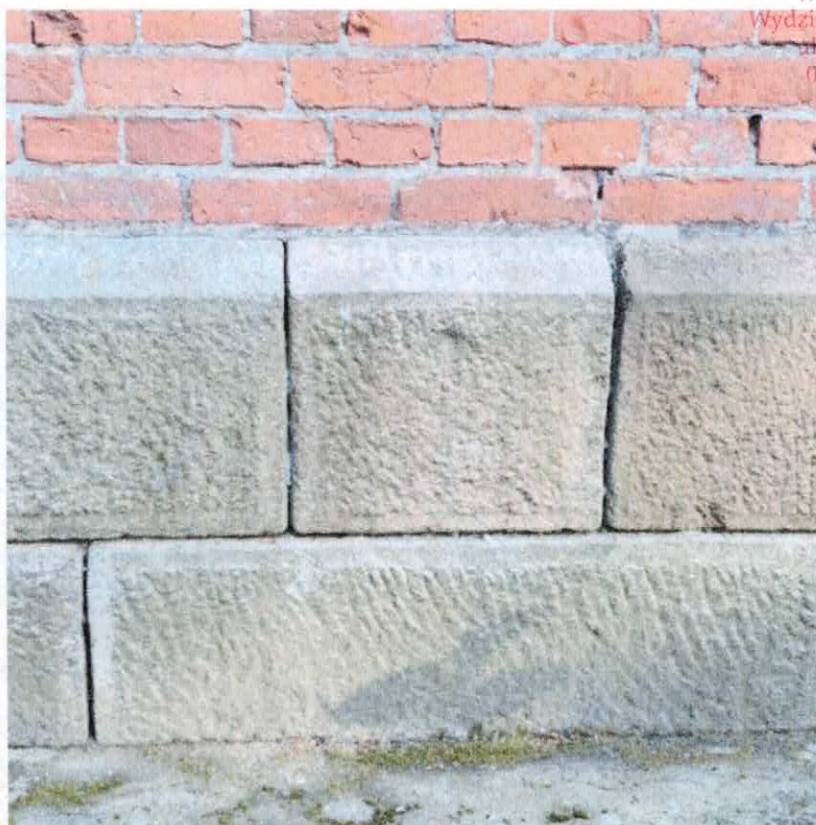
Fot. 20 Szczegół braku spoinowania cokołu kamiennego ścian kościoła
