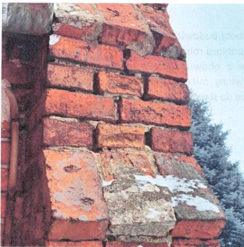
Fot. 3 Widok zniszczenia ścian elewacji kościoła (szkarpy kruchty)
