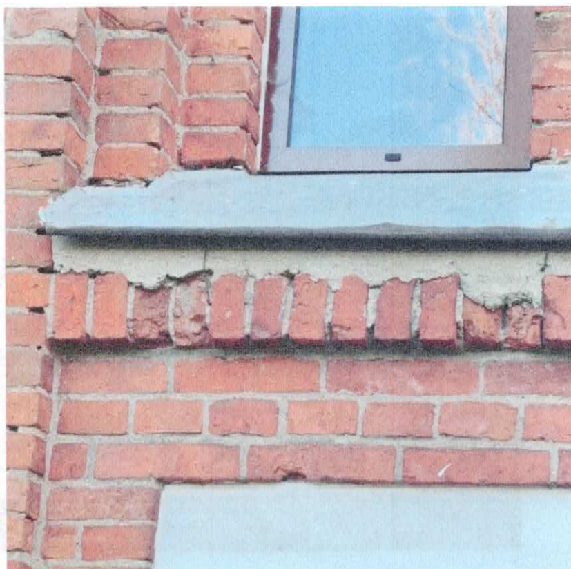
Fot. 8,9 Szczegół przedstawiający stan naprawy ubytków muru poprzez „flekowanie” zaprawą cementową.
