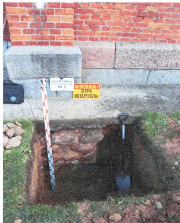
Fot. 1,2 Odkrywki kontrolne nr 1 i 2 fundamentów kościoła
