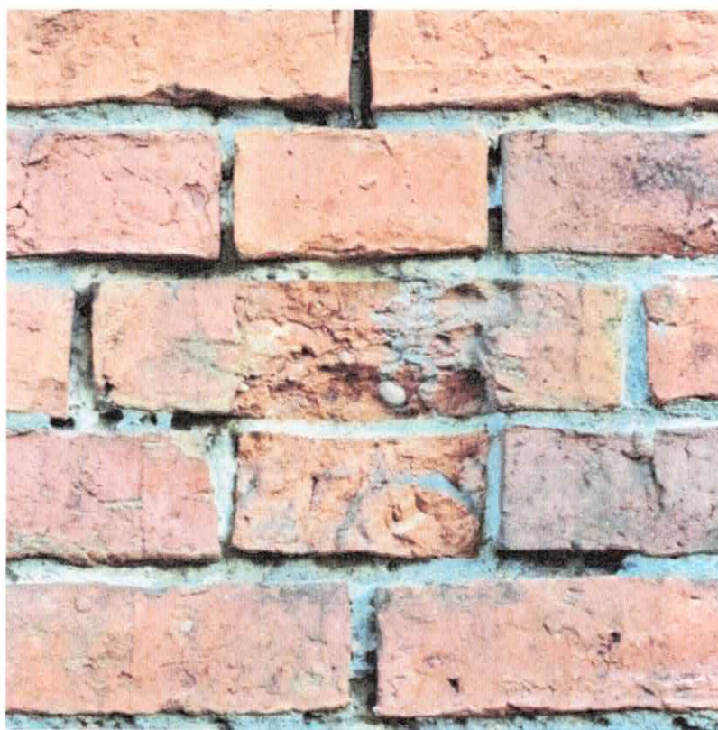
Fot. 6,7 Widok uszkodzeń wojennych muru i stanu spoinowania elewacji ścian kościoła.
