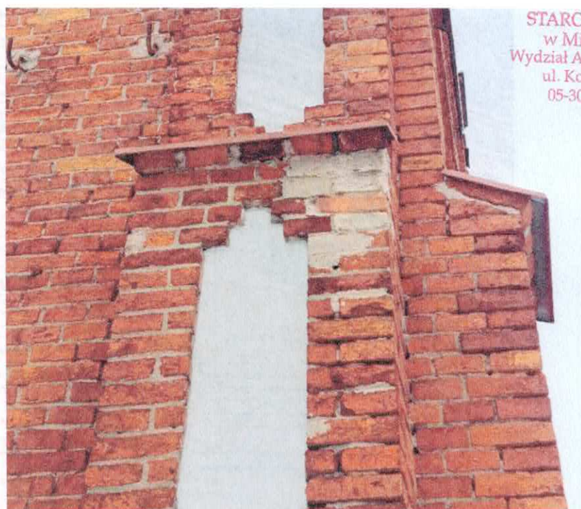
Fot. 8,9 Szczegół przedstawiający stan naprawy ubytków muru poprzez „flekowanie” zaprawą cementową.
