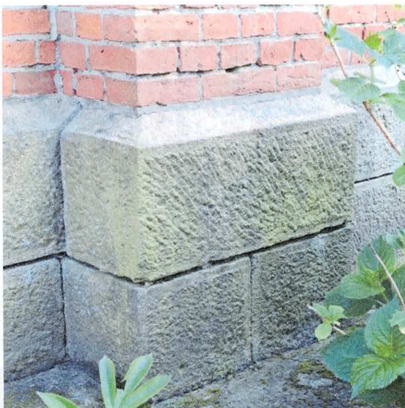
Fot. 17 Widok przedstawiający ogólny stan porażenia przez mikroby murów oraz cokołu kościoła. Skutek zawilgocenia ścian.
